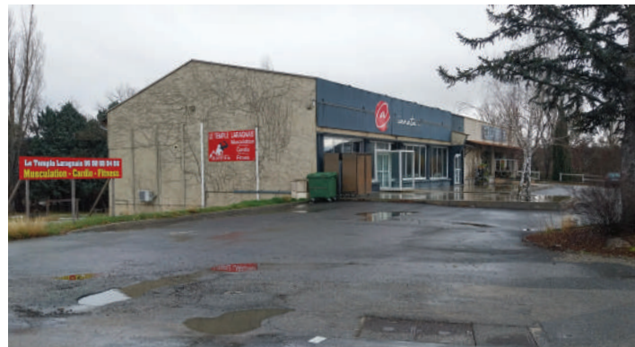
Zone d'activité Le Plan (Laragne) 12 hectares activités commerciales, artisanales et de service
