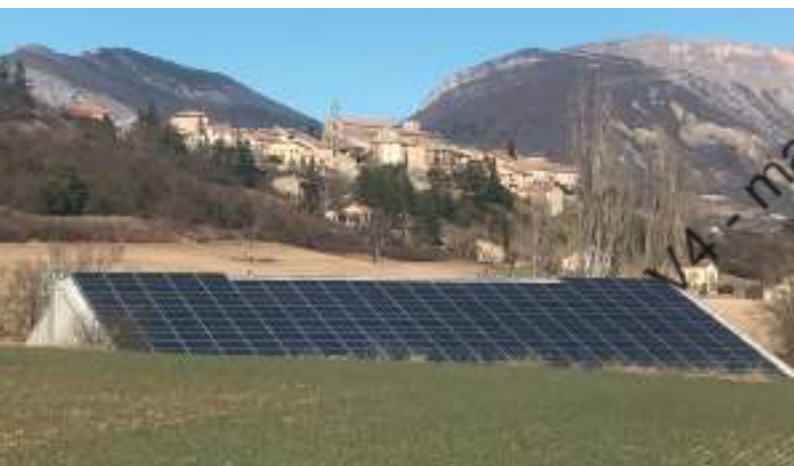
Toit de panneaux photovoltaïques à Lagrand _Cittànova
