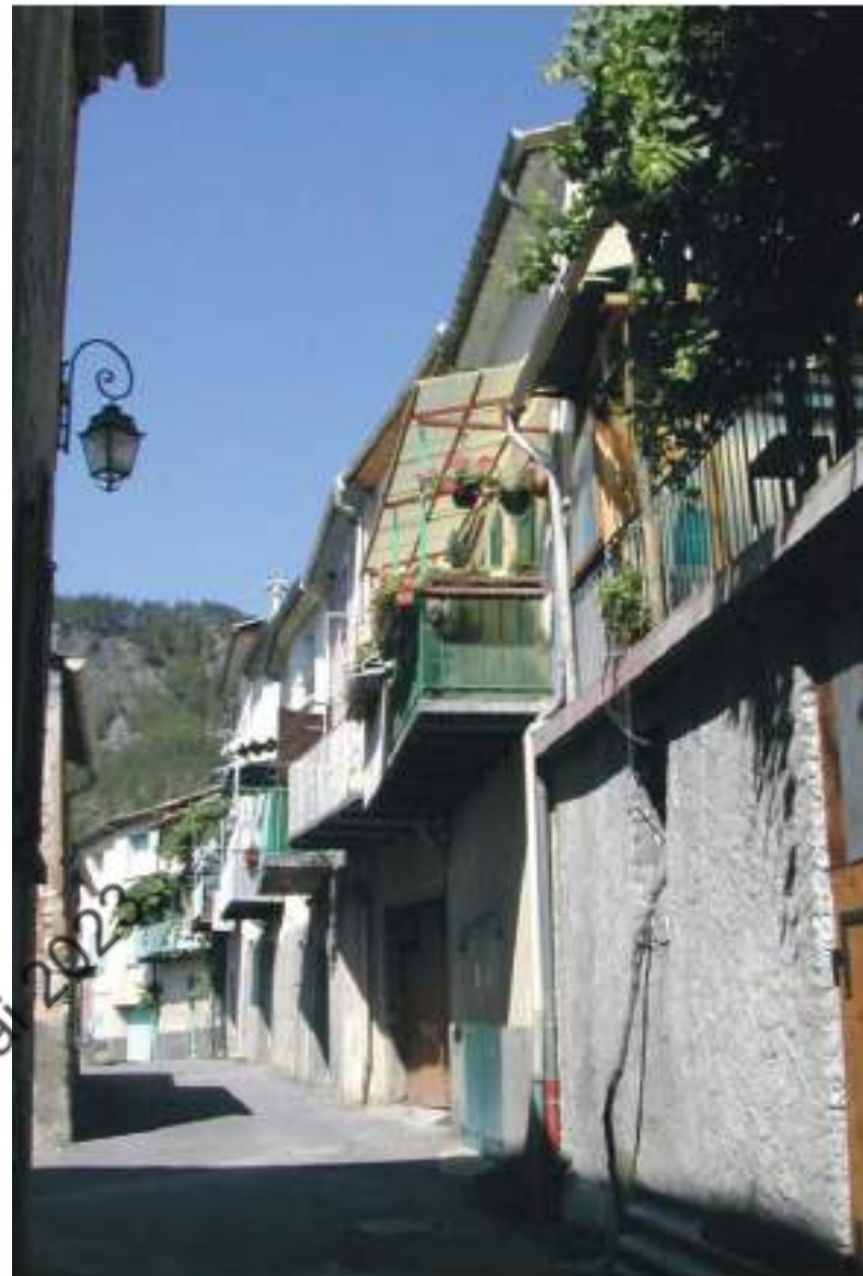
Maisons accolées ornées de balcons en béton du centre-ville, La-Motte-du-Caire
