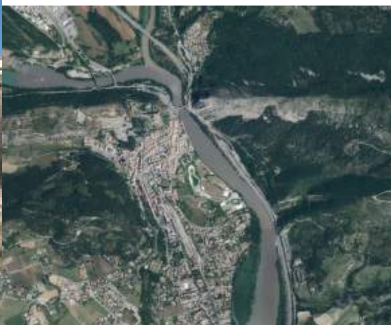
Sisteron, construite entre Eau et Montagne _Orthophoto
