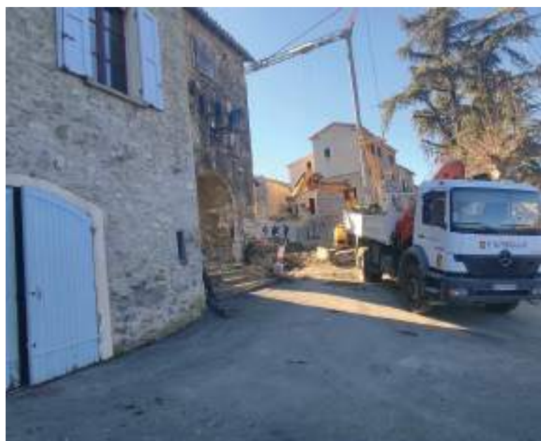
Travaux de rénovation, Ventavon_Cittànova
